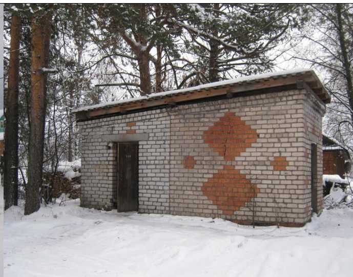
Рисунок 9.2.2 – Здание КНС ул. Ленина городской парк
