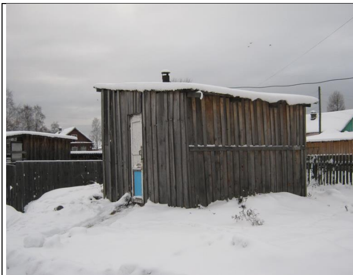
Рисунок 9.2.1 – Здание КНС ул. Вокзальная,48
