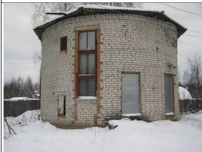
Рисунок 9.2.5 – Здание КНС ул. Ленина (станция перекачки 2 агрохимия)
