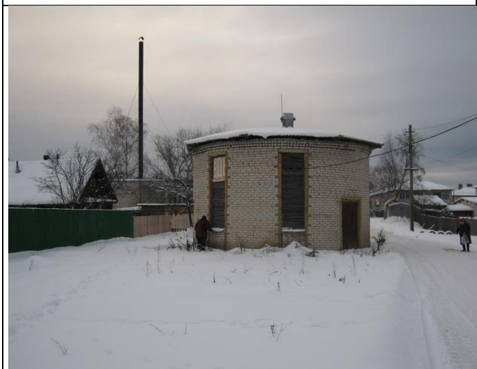
Рисунок 9.2.3 – Здание КНС ул. Ленина (станция перекачки 1 агрохимия)
